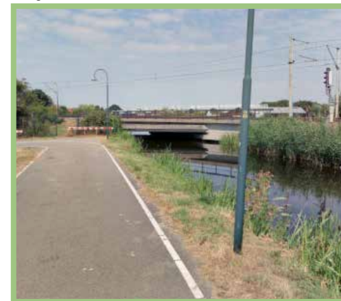
Doorsnijding oorspronkelijk lint door infrastructurele ingrepen
